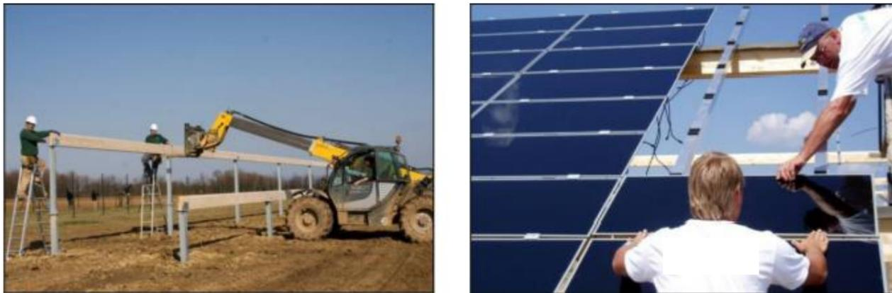
Illustration 37 : Montage des structures porteuses et des modules
